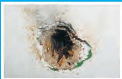
▲ 完好的墙壁被白蚁破坏
